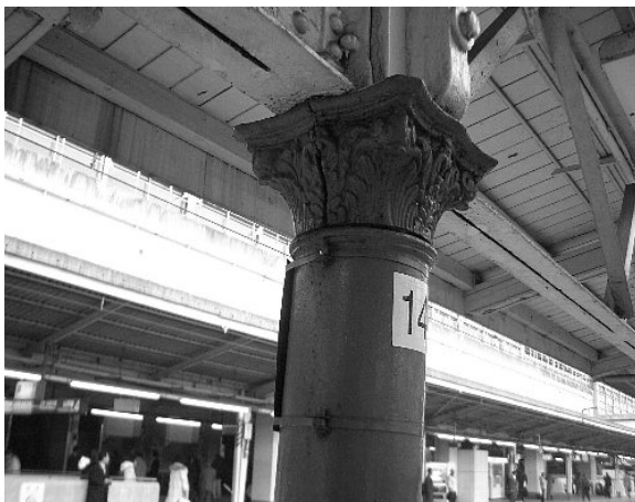
東京駅の京浜東北線品川方面のホーム 開業当初からホーム屋根を支えている柱
