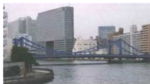
図-6 吊り橋型の清洲橋。ドイツケルン市に架けられたライン河の吊り橋がモデルとなっています
