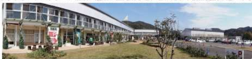
道の駅・保田小学校の全景、1階はレストランや案内所、2階は宿泊施設に、校庭が駐車場。
